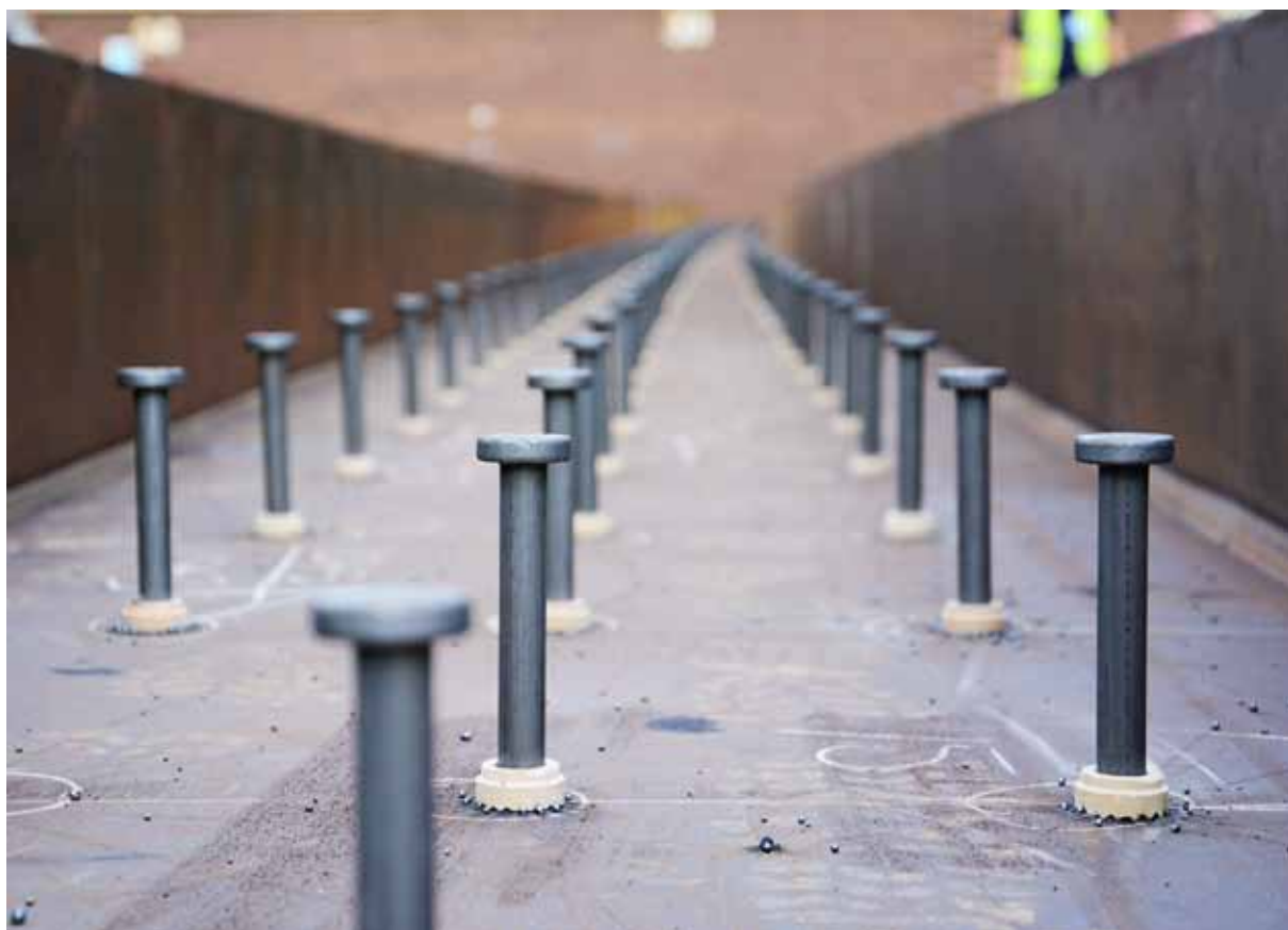
Стальная конструкция, изготовленная сварщиками компании SWUK Steel Decking Ltd (Великобритания) с 30-летним опытом работы с упорами
