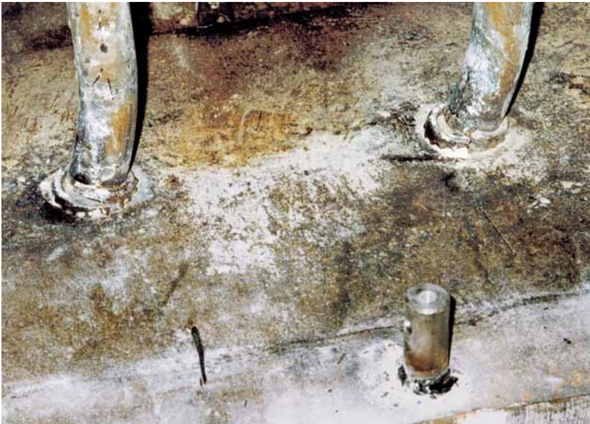
Исследование сопротивления усталости пояса с гибкими упорами. Разрушение образца № 9 по зоне несплавления между телом упора и кольцевым валиком
