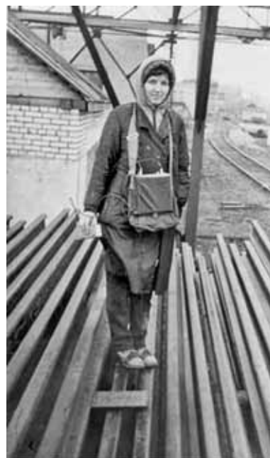
Измерения дефектоскопом «ПОИСК-4» на стеллажах РСП-21, г. Лодейное Поле (А. В. Максимов и Е. Л. Федорова)
