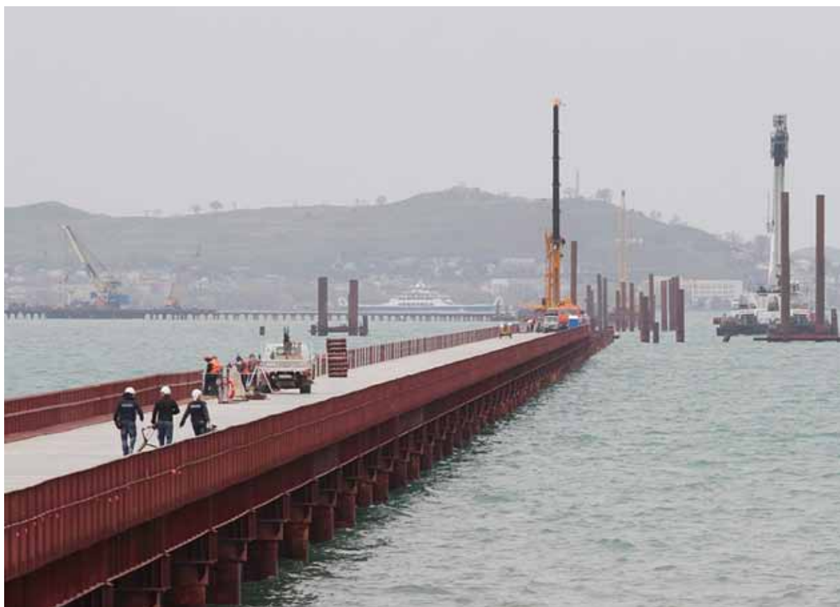
Возведение моста через Керченский пролив с применением метода погружения свай оболочек большого диаметра, разработанного НИИ мостов в 50-е годы
