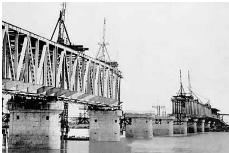
Общий вид строительства моста «Тханг-Лонг» близ Ханоя
