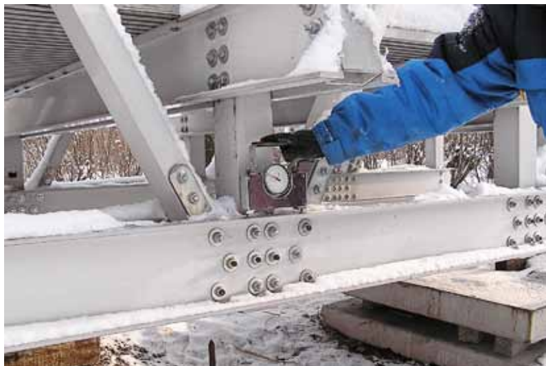
Измерение деформаций нижних поясов ферм компаратором НИИ мостов
