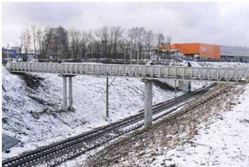
Пешеходный мост у остановочной платформы Чертаново в Москве. Первый мост из композитных материалов производства ООО НПП «АпАТЭК-Дубна»
