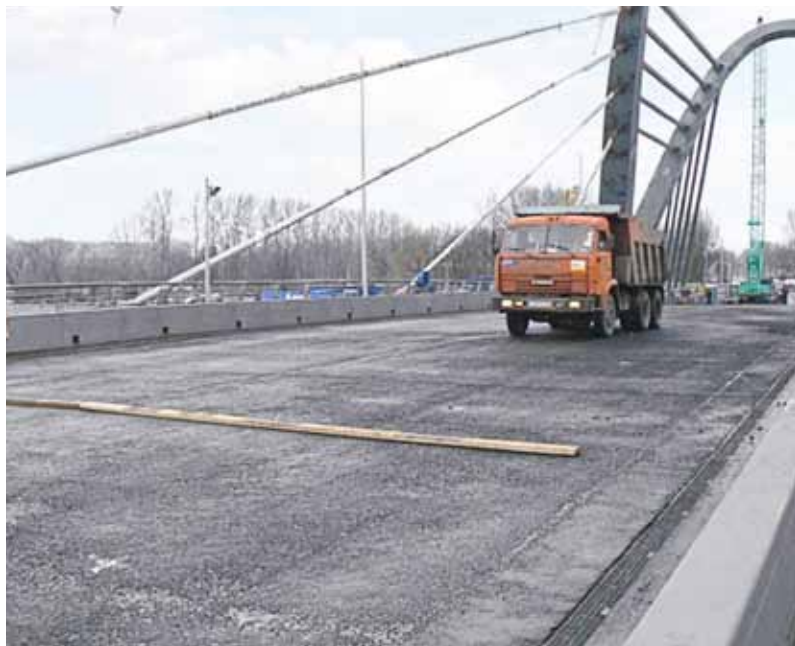
Проведение динамических испытаний Лазаревского моста с использованием порожка
