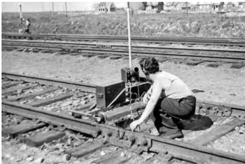
УЗК болтовых отверстий рельсов (А. С. Кукли, 1958 г.)
