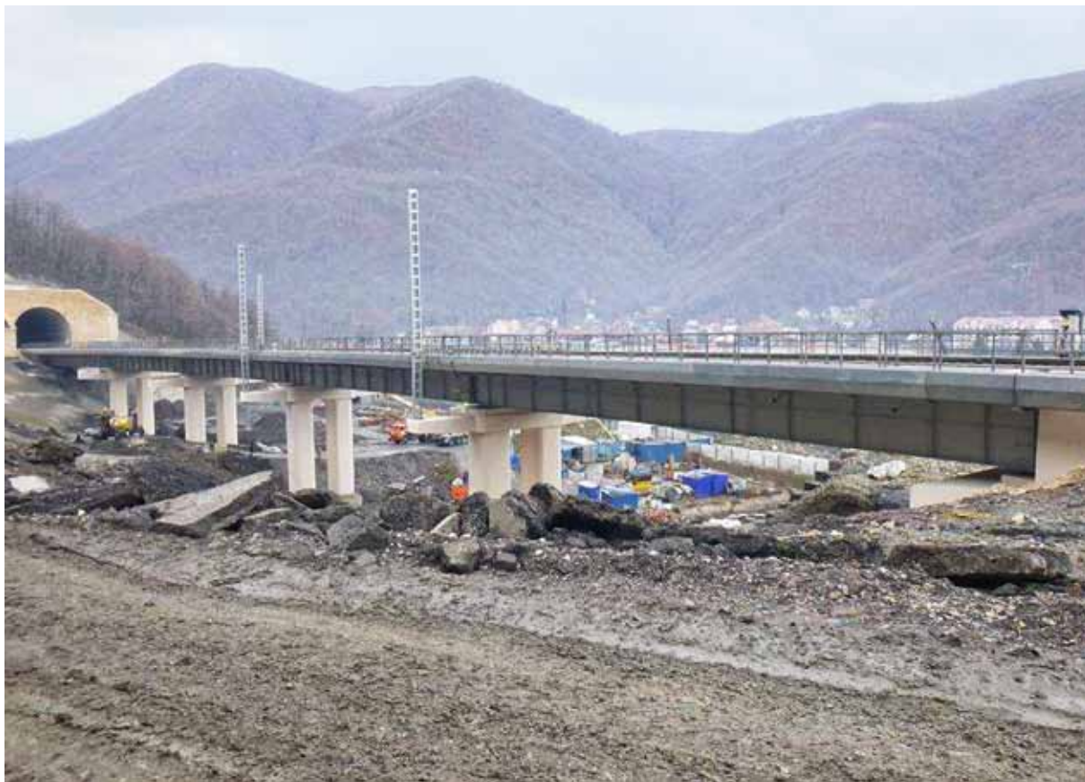
Общий вид моста на пикете 456 + 20, железная дорога Адлер — Альпика-Сервис
