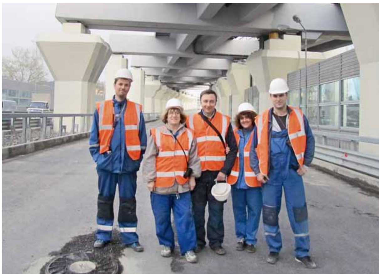
Участок эстакады 2 съезда 2 с железобетонными неразрезными пролетными строениями на встроенных ригелях на подходе к мосту через реку Мзымту. Сотрудники НИИ мостов на обследовании эстакады. Слева направо: Д. Н. Степанов, И. В. Рупасова, В. В. Кондратов, М. А. Мухина, А. С. Дудик
