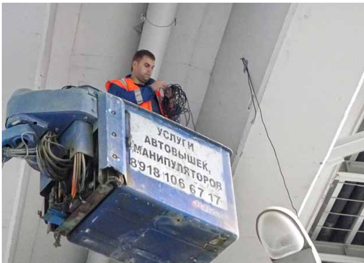
А. С. Дудик устанавливает индуктивные датчики для измерения напряженного состояния пролетного строения эстакады
