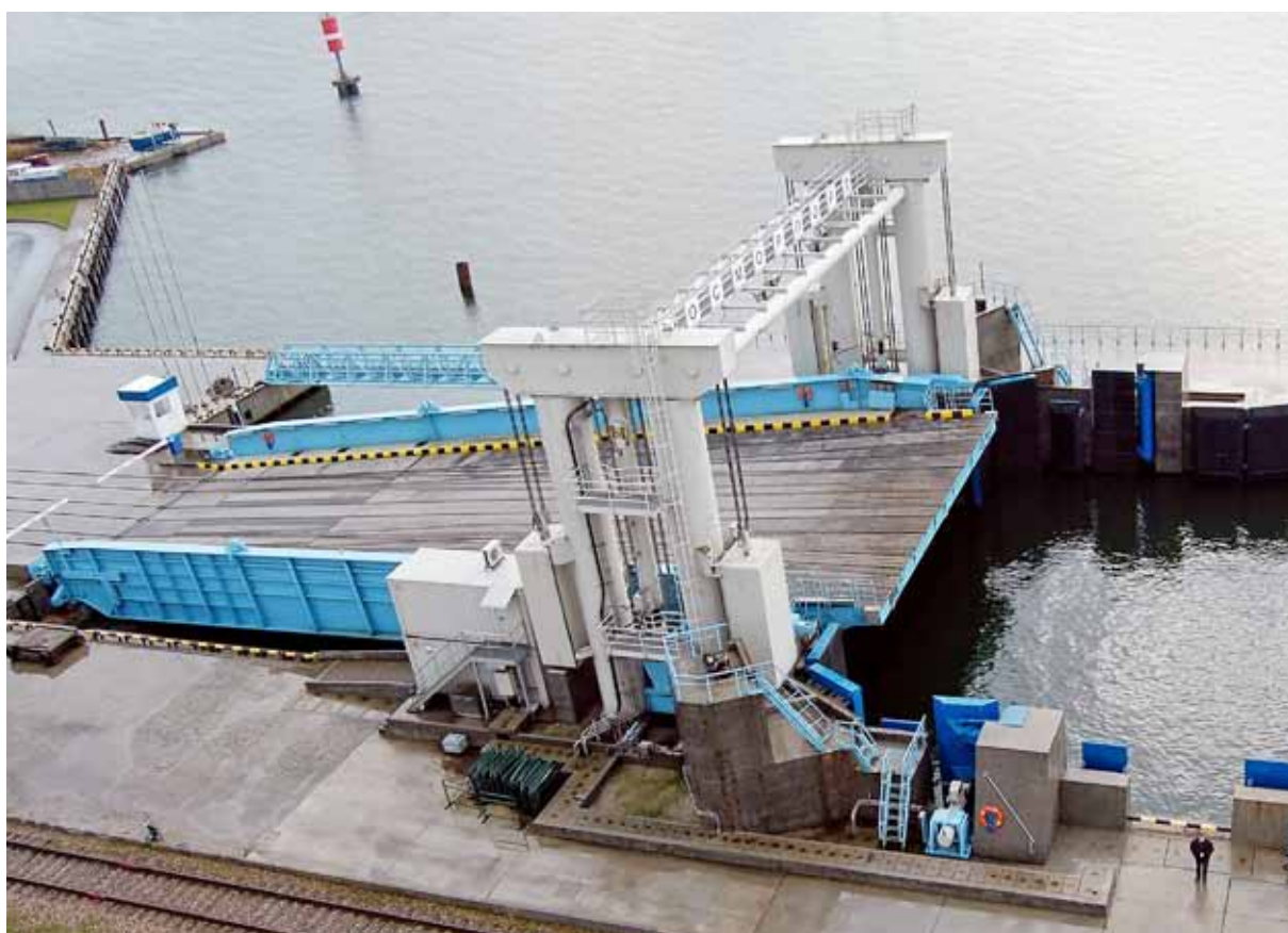
Подъемно-переходной мост железнодорожной паромной переправы в г. Балтийск
