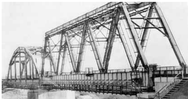
Первые цельносварные пролетные строения конструкции профессора К. Г. Протасова (на переднем плане) и академика Е. О. Патона на мосту через реку Болву около Брянска
