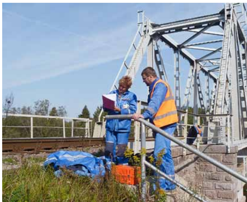
Обследование сотрудниками НИИ мостов железнодорожного моста через реку Суур-Эмайыги на км 419 + 93 перегона Тапа — Тарту в 2015 году
