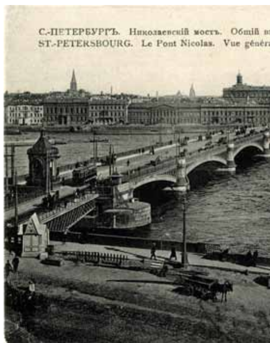
Благовещенский мост — первый постоянно действующий мост через Неву. Построен в 1850 г. При его реконструкции в 1936–1937 гг. впервые были применены металлические пролетные строения со сварными заводскими соединениями
