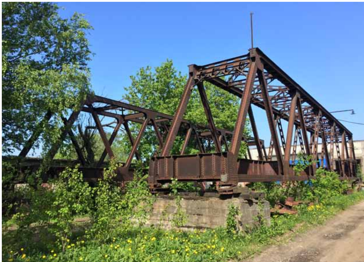
Опытный образец цельносварного пролетного строения, разработанный НИИ мостов
