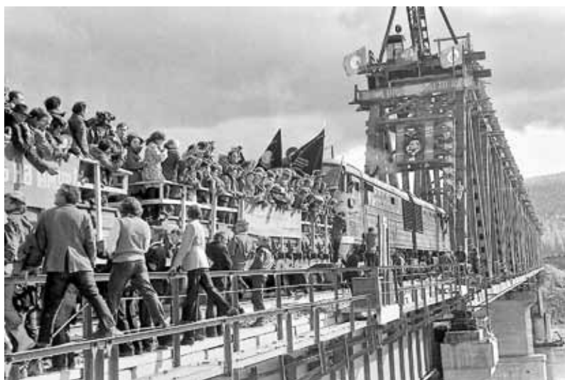
Пуск железнодорожного моста через реку Лену в Усть-Куте в 1975 г. Фото Михаила Москвина
