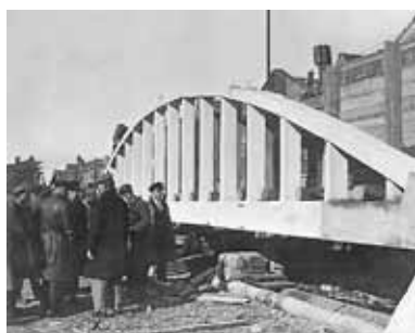
Испытание модели арок на строительстве Володарского моста (1930-е годы)
