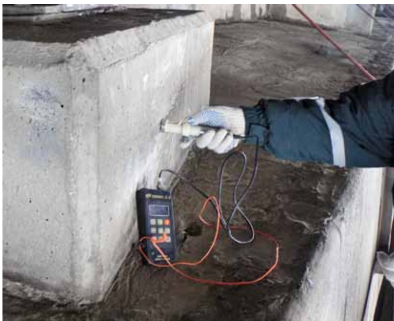
Проверка прочности бетона опор Лазаревского моста прибором ОНИКС-2,5
