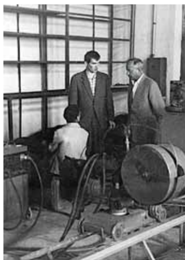
Заведующий лабораторией сварки Шишкин Василий Юлианович и научный сотрудник Кауган Владимир в цехе у сварочного автомата типа АДФ-2
