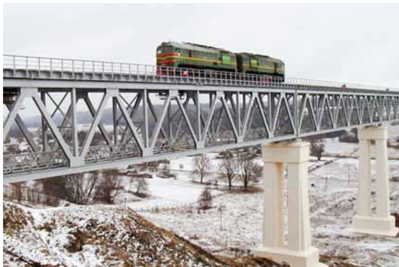
Сплотка локомотивов на мосту через реку Дубису во время статических испытаний
