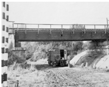
1960-е годы. Типовое болто-сварное сплошнотенчатое пролетное строение
