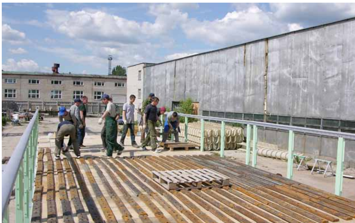
Нагружение пролетного строения испытательной нагрузкой
