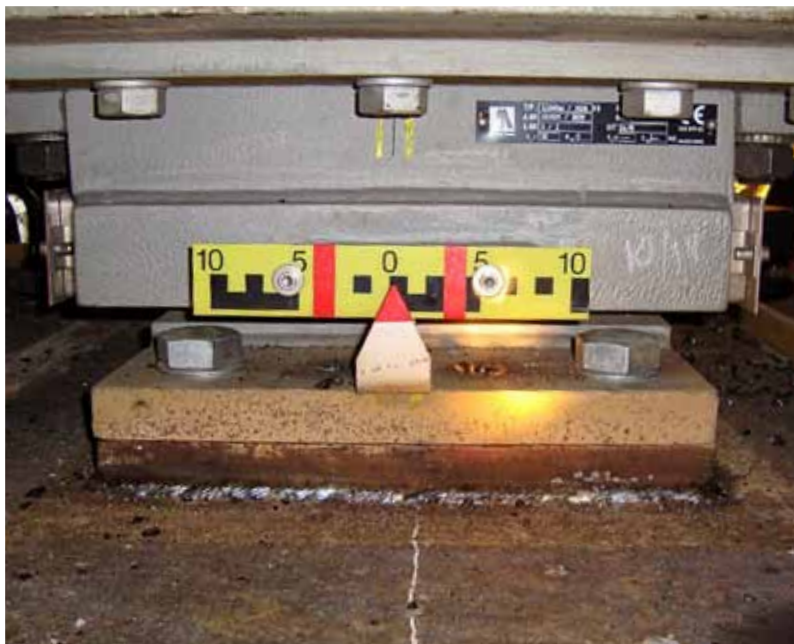
Измерение положения подвижных опорных частей Лазаревского моста
