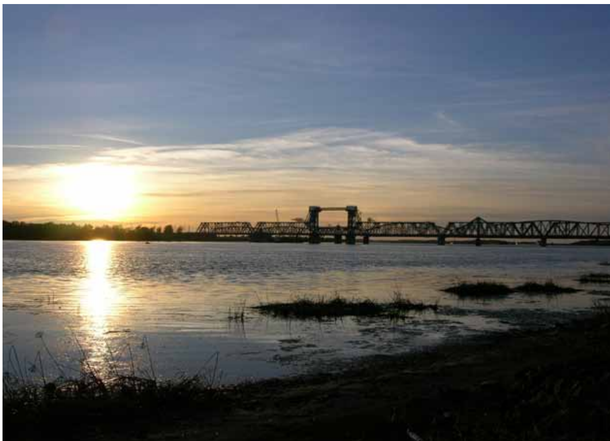
Пролетное строение моста с безбалластным мостовым полотном на строящейся линии Лосево — Каменогорск. 2015 г.
