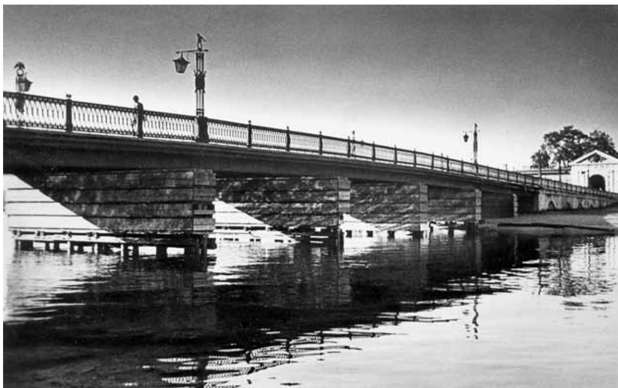
Иоанновский (до 1887 г. — Петровский) мост. Построен на месте первого наплавного моста Санкт-Петербурга, соединившего острова Заячий и Городовой (ныне Петроградская сторона)
